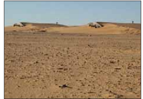
Wadi Doum, le 8 mai 2011 - Les hangars de l'aéroport militaire sous le sable. L'environnement de Wadi Doum reste relativement hostile.
