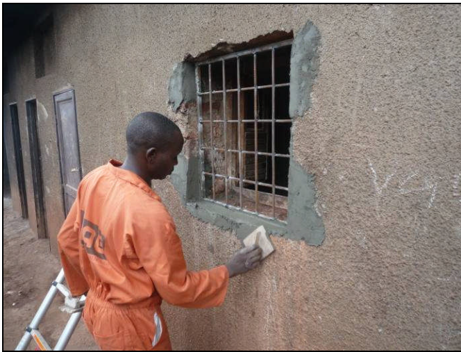
Un membre de l'équipe MAG pour la défense passive renforce une fenêtre du poste de police de Muyinga, Région de police Est.
