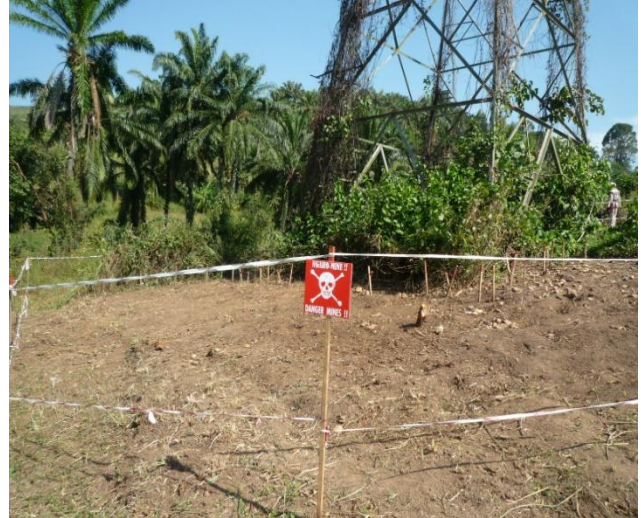
Un pylône presque nettoyé. Une fois que la tâche est complétée, la terre est toute de suite remise à la population locale.
