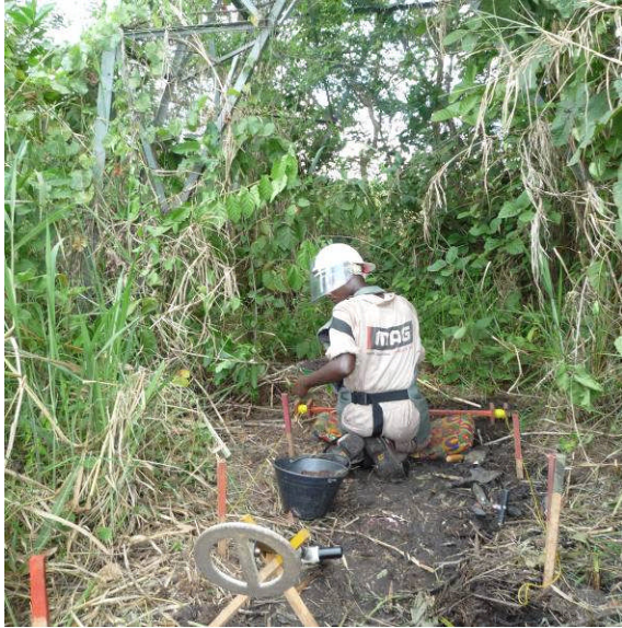
Déminage manuel autour d'un pylône électrique
