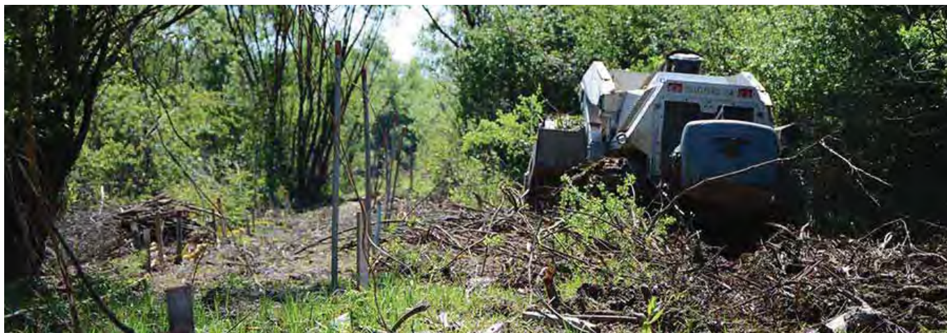
Ouverture d'une voie d'accès par la DIGGER D-3
