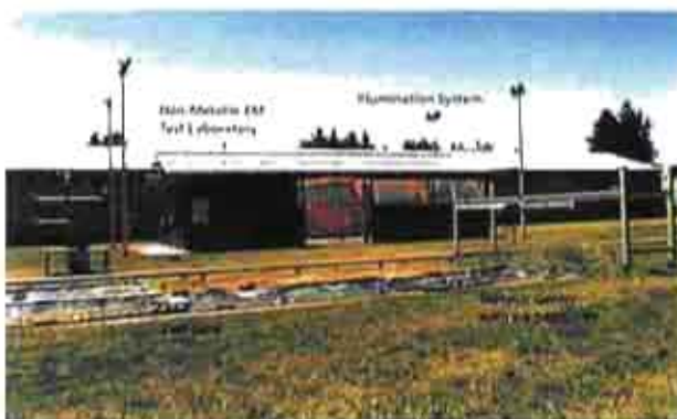
Vue de l'installation d'essai en plein air du CCR
