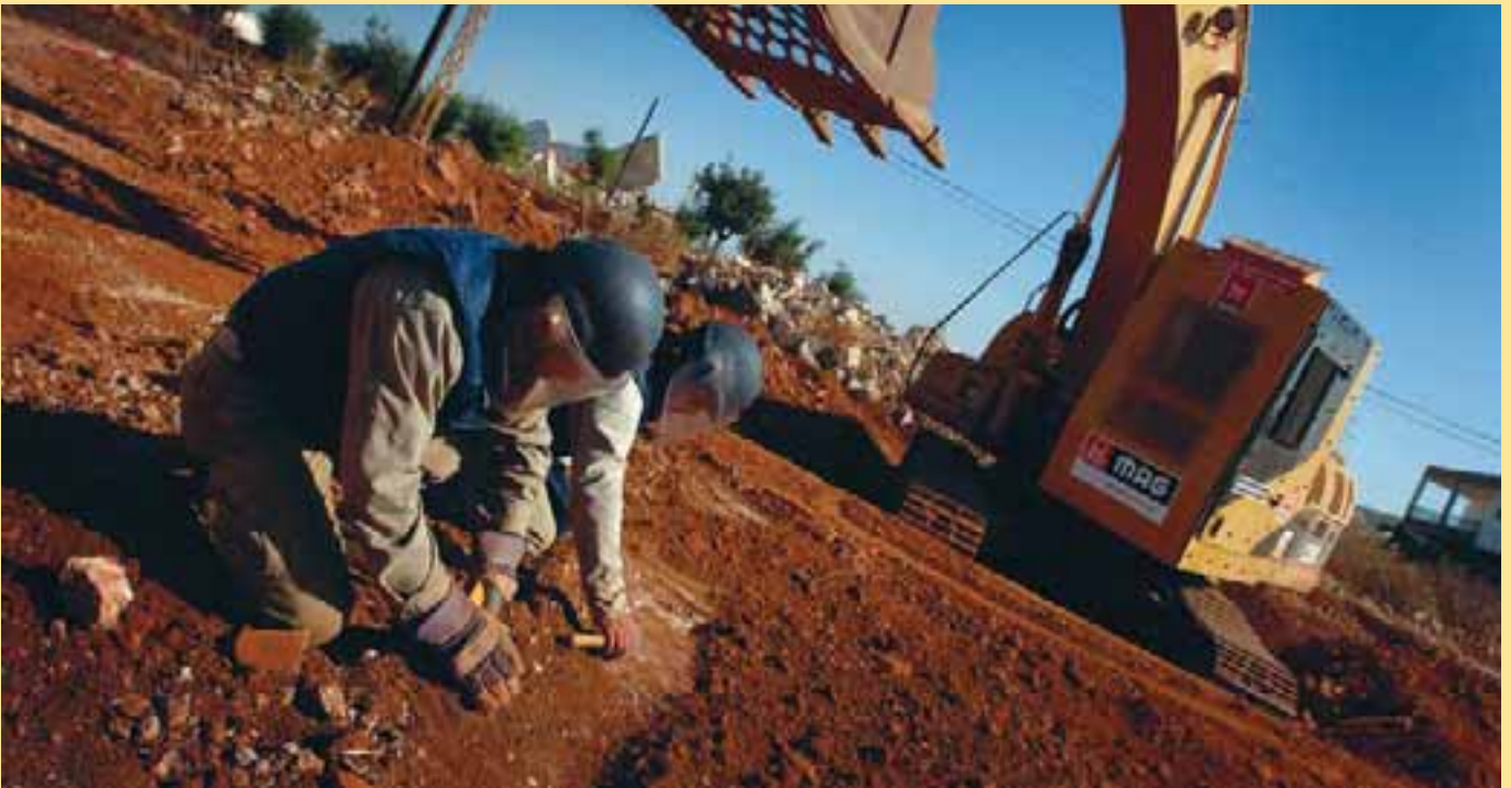
Un excavateur blindé équipé d'un godet cribleur spécialement conçu par MAG est utilisé pour chercher dans les ruines de maisons, ce qui permettra aux populations de reconstruire en toute sécurité.
