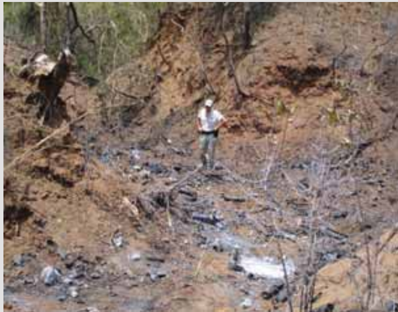
Didier Leonard, responsable technique sur le terrain de MAG, évalue le site de démolition à Mudubugu.
