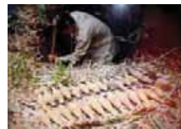
Visite d'un chantier de déminage
