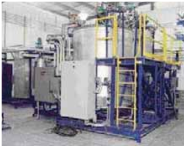
Figure 7.2 : Installation de dégradation biologique
