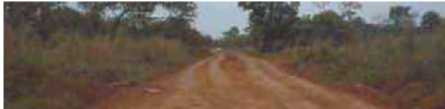
Une route en terre
