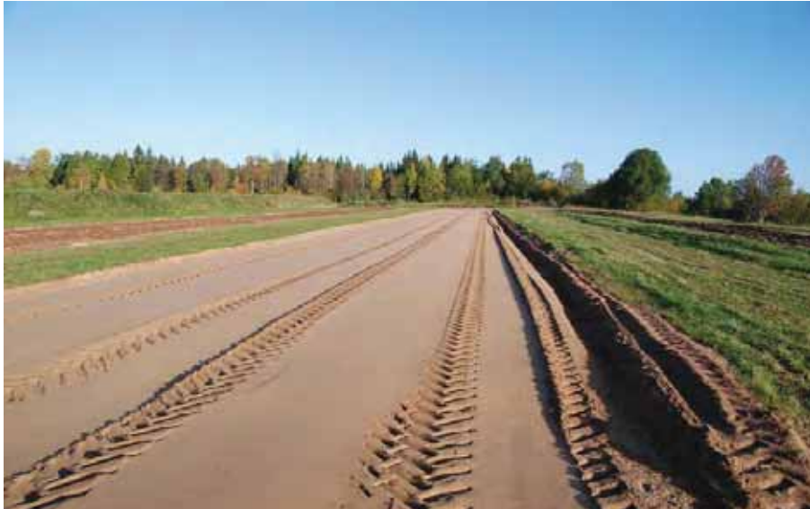
Figure 4 : couloir de test préparé avec le sol compacté image © GICHD
