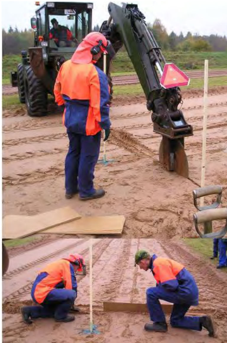
Image 3 : Installation correcte des panneaux de bois aggloméré
